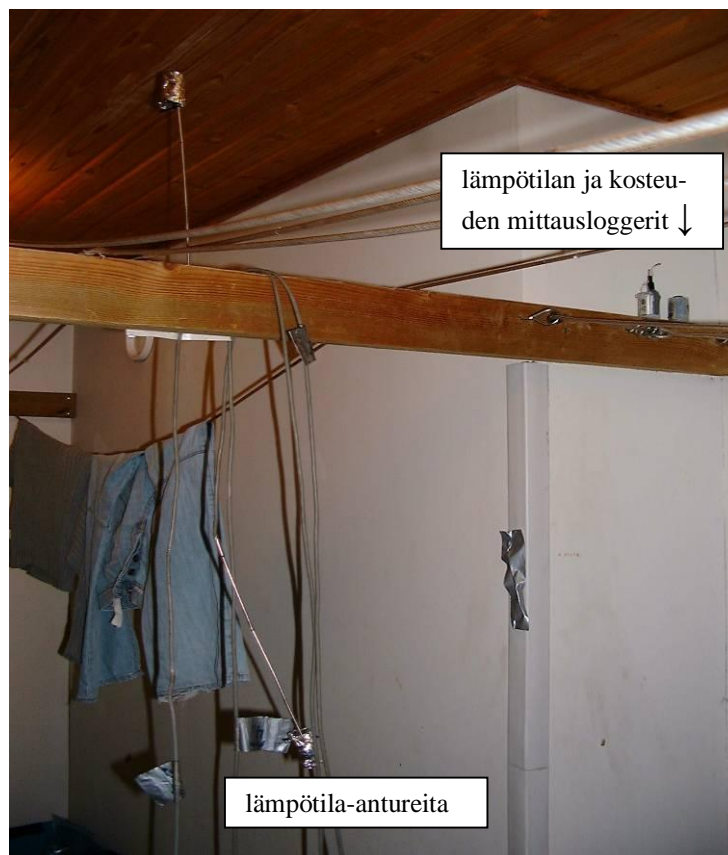
Kuva 7. Lämpötilojen ja ilman suhteellisen kosteuden mittaaminen.
